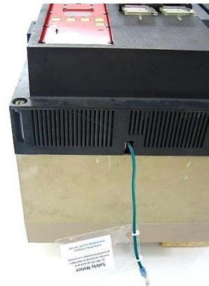
Ao recolocar a tampa frontal do disjuntor, direcione o fio de aterramento curto para que ele passe através da parte quebrável na tampa.
