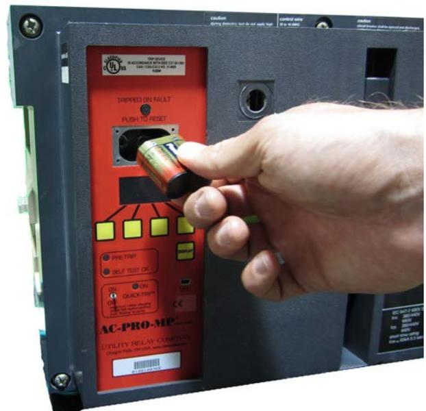
Remova a bateria antiga e instale uma nova bateria de lítio de 6 volts, CR-P2.
