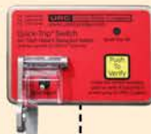
QT2-Switch na parte frontal da porta do cubículo
